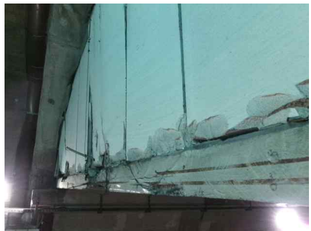
RAMP-D 풍도슬래브 S54 격벽 파손 및 철근노출
