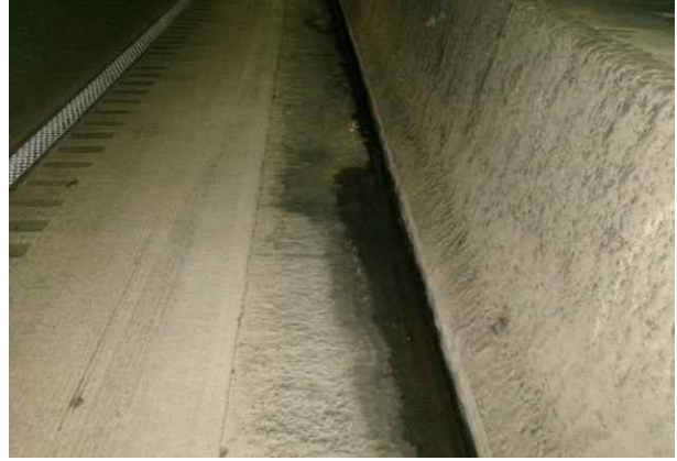
본선 배수시설 S378~385 배수로 채수
