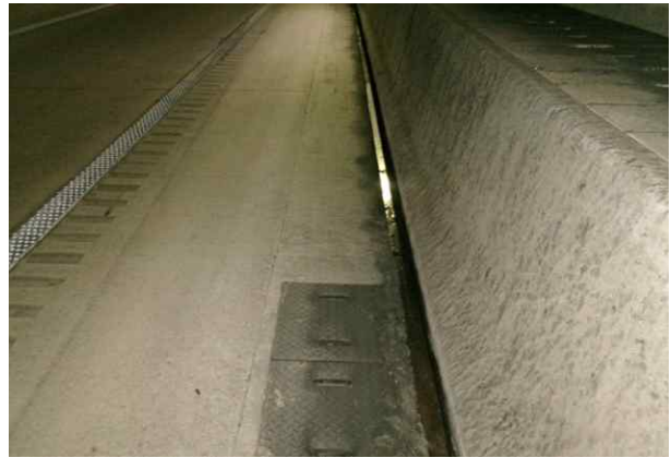
본선 배수시설 S378~385 배수로 채수
