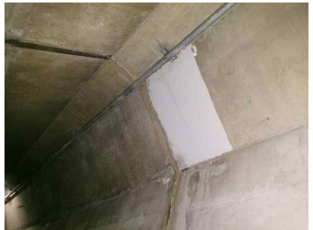
RAMP-D BOX구간 벽체 누수보수 양호
