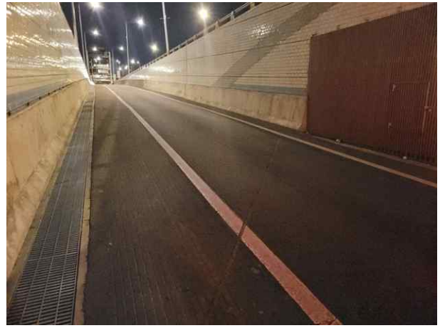
RAMP-D U-TYPE 옹벽 전경
