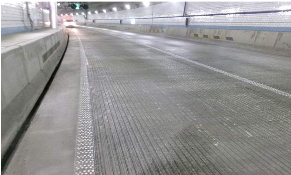
BOX구간 포장 전경
