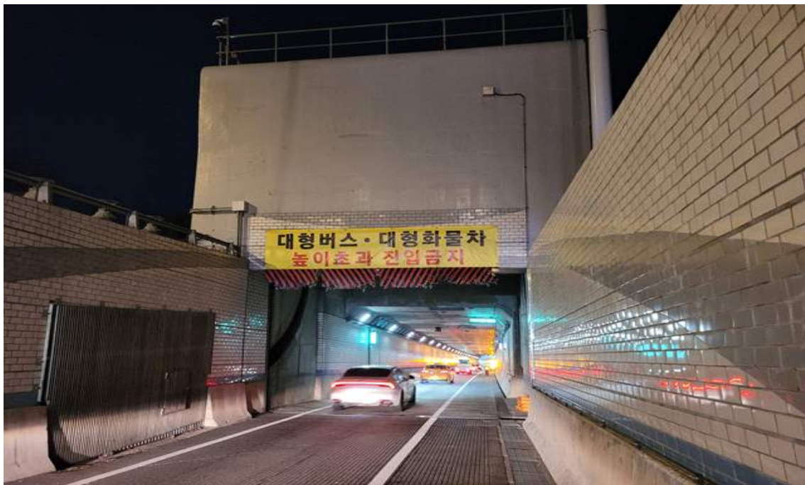
RAMP-D 갭문 진입부 전경
