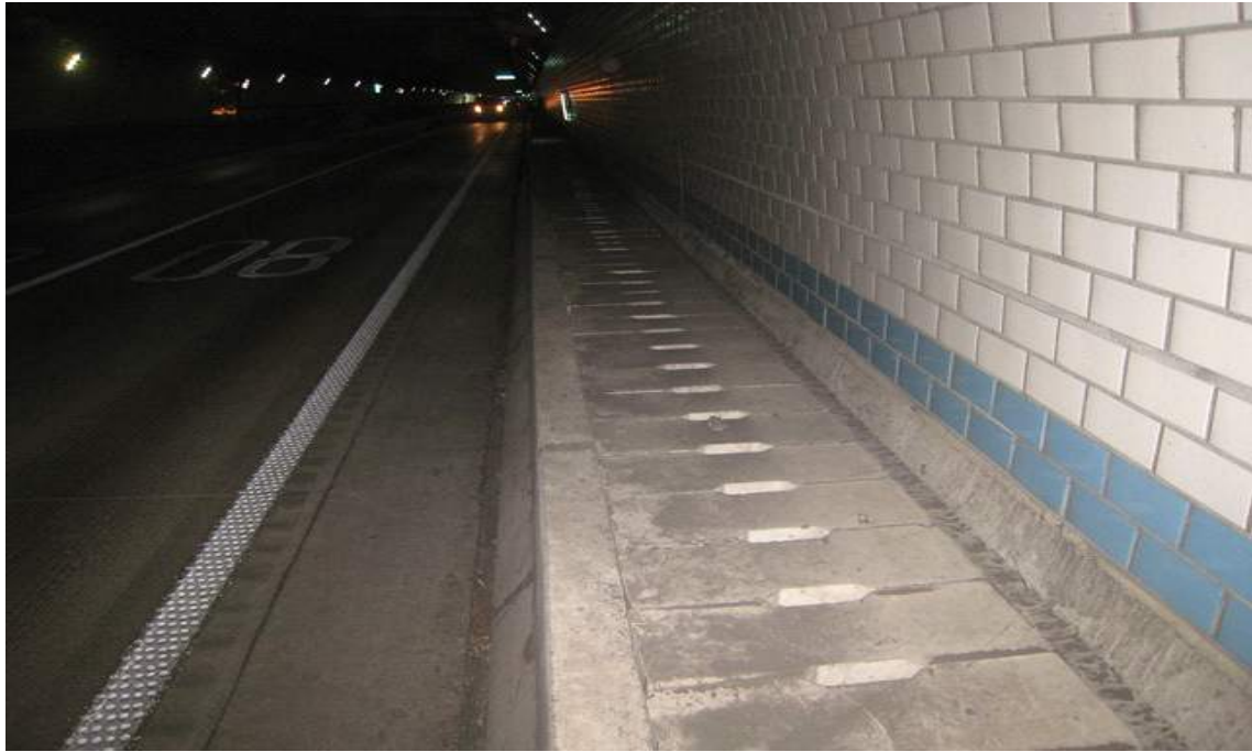
NATM구간 공동구 전경
