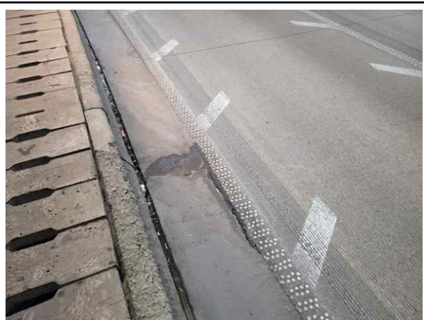
RAMP-D 포장부 S45 체수
