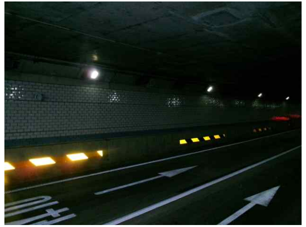
본선 BOX구간 벽체 전경
