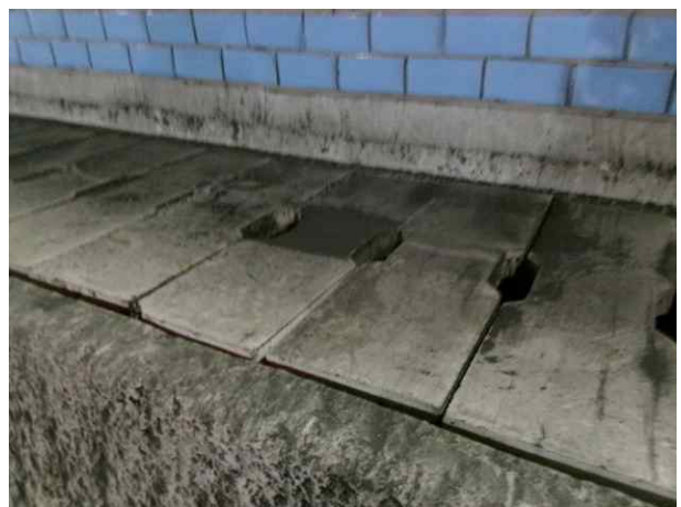
본선 공동구 덮개파손 보수 양호
