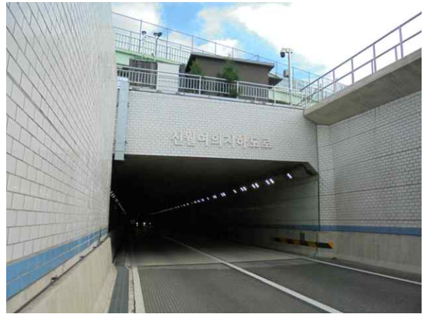
갯문 종점부 상태양호
