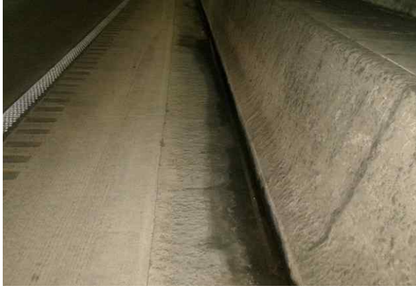
본선 배수시설 S378~385 배수로 채수
