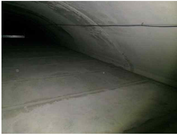
본선 NATM구간 풍도슬래브 상면 전경
