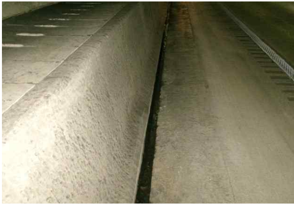
본선 배수시설 S378~385 배수로 채수
