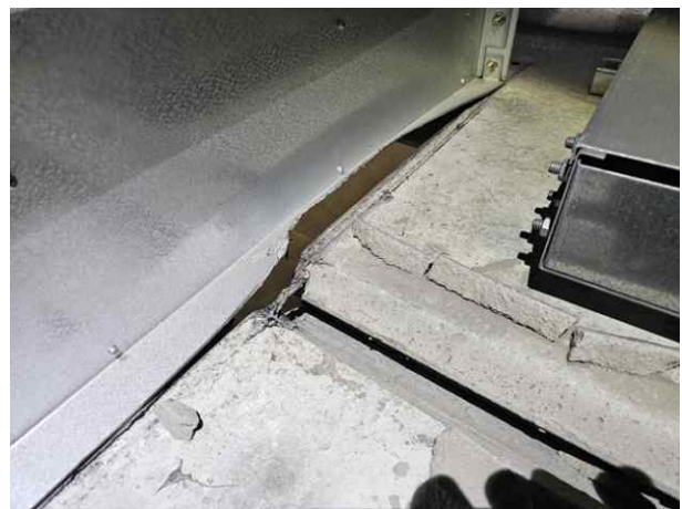
RAMP-D 풍도슬래브 S53 댐퍼 덮개탈락 및 파손
