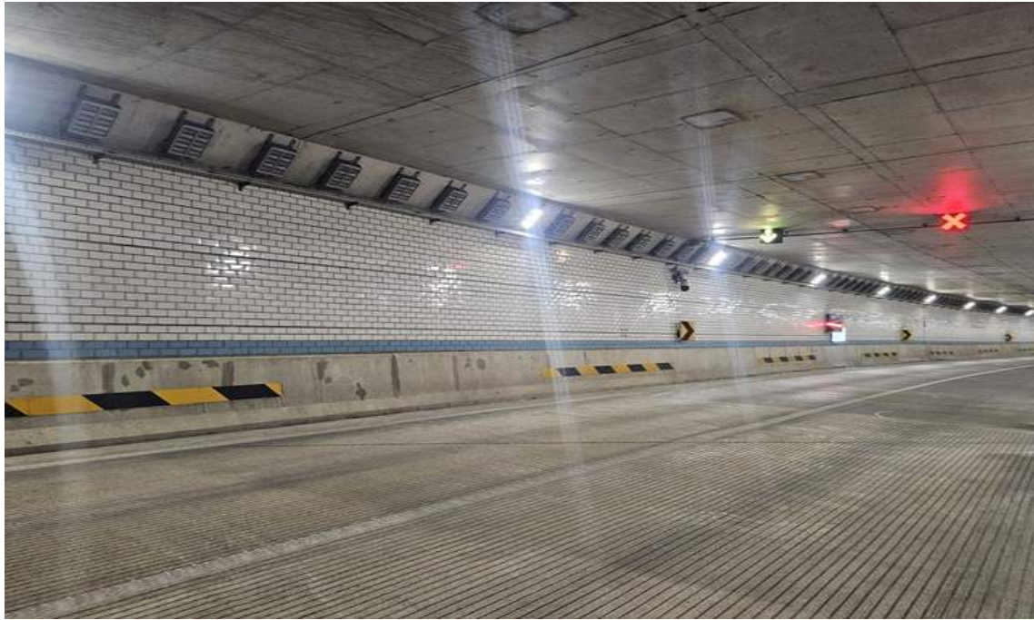
BOX구간 벽체 전경
