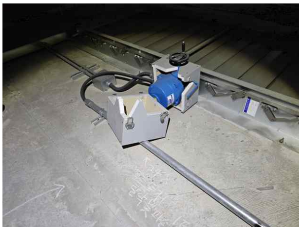
RAMP-D 풍도슬래브 S53 댐퍼 덮개탈락 및 파손
