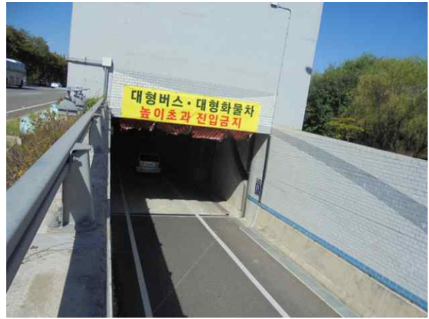
갯문 진입부 상태양호
